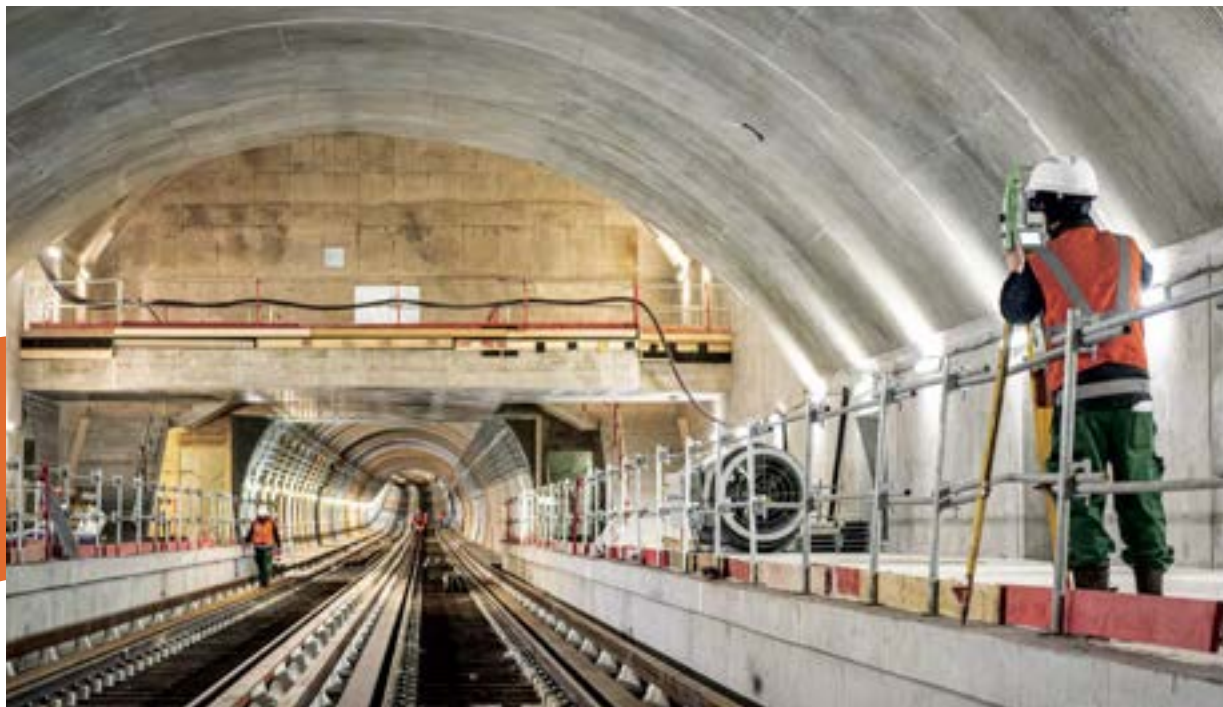
Chantier de prolongement de la ligne 4.
